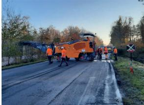
Les travaux réalisés sur le RD408 consistaient à renouveler la couche de roulement en ajoutant un nouvel enrobé.
